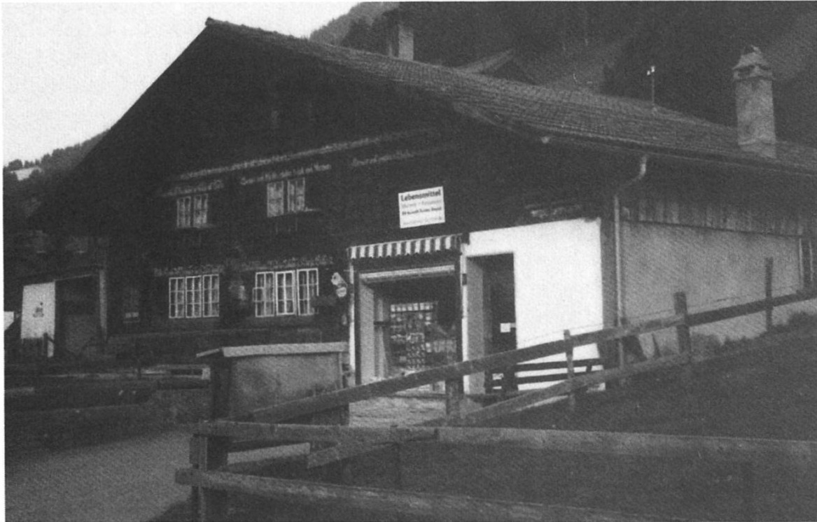
Haus von Daniel Schranz im Ausserschwand, kurz vor Schliessung des Ladens 1995. Foto: Alfred Bircher
