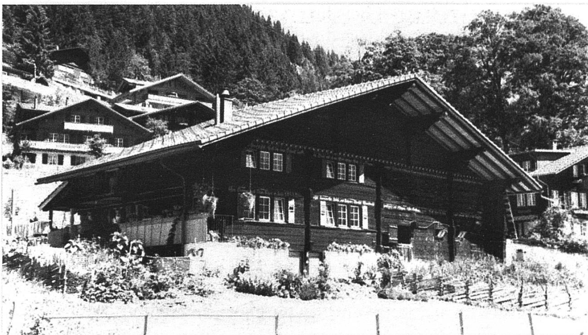
Das Bauernhaus an der Senggistrasse 1
