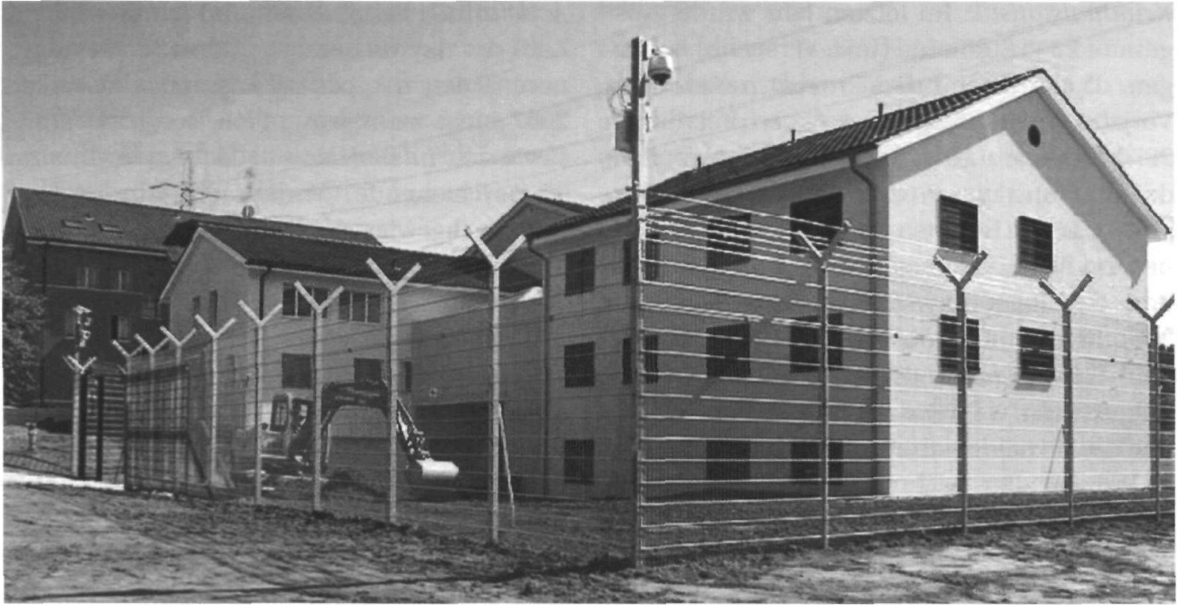
Das neue kantonale Untersuchungsgefängnis in Gmünden ist bezugsbereit.
