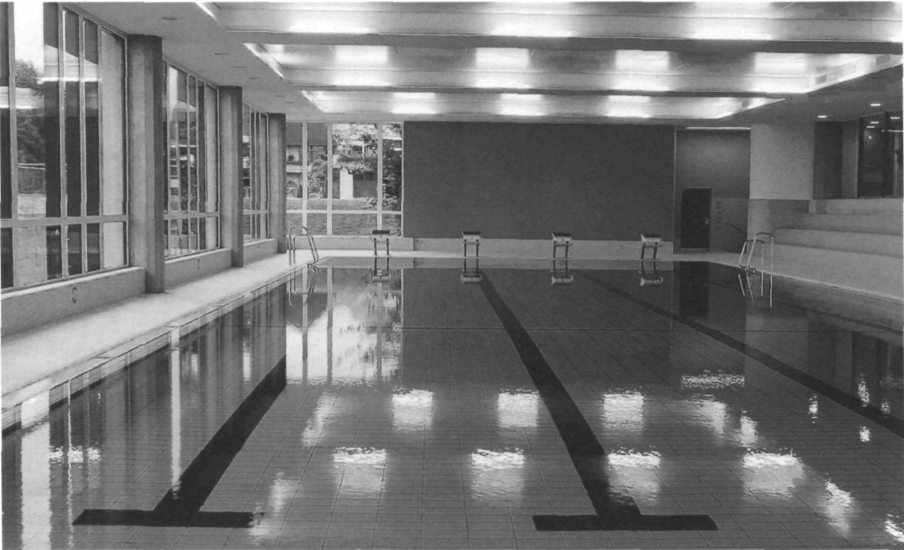
Die Sanierung des Hallenbades Speicher konnte erfolgreich abgeschlossen werden.
