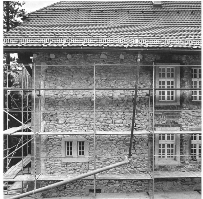
Abb.121: Saanen, Pfarrhaus. Baugeschichtliche Aufschlüsse Nordfassade.
