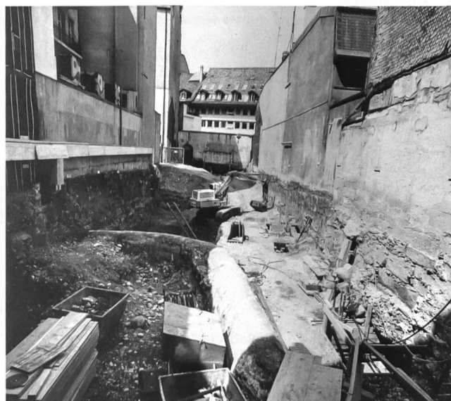
Abb.80: Bern, Spitalgasse 38. Ehgrabenaufschluss nach Norden.
