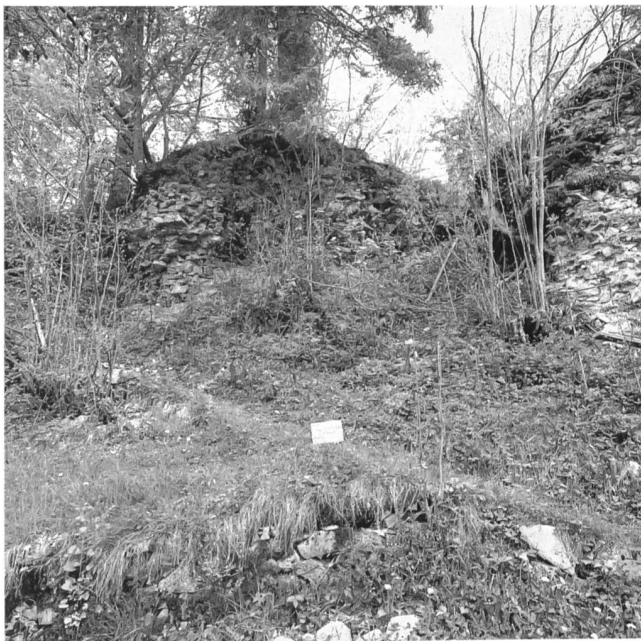
Abb.97: Därstetten, Ruine Weissenburg. Donjon vor der Sanierung.
