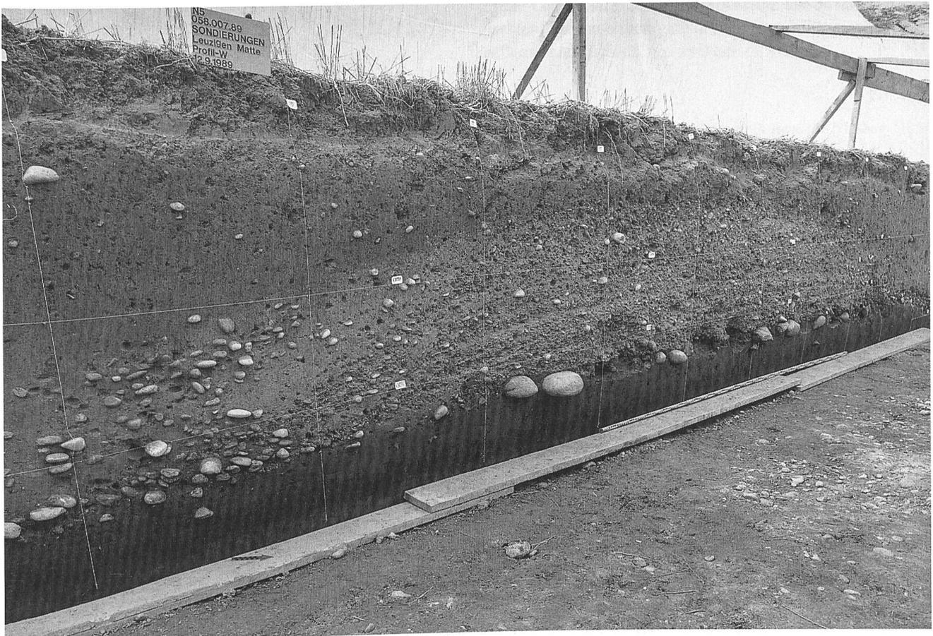
Abb. 24: Leuzigen-Matte 1989. Profilschnitt 1. Strassenkörper mit verschiedenen übereinanderliegenden Fahrbahnen. Blickrichtung Nordwest.
