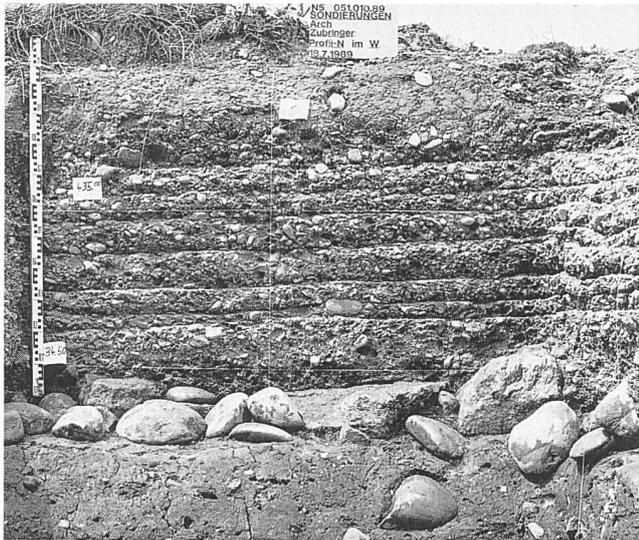
Abb. 18: Arch-Römerstrasse West 1989. Profilschnitt 43. Längsprofil durch die römische Strasse. Über der Geröll- und Bruchsteinkofferung zeigen sich innerhalb des Kieskörpers verschiedene übereinanderliegende Fahrbahnen. Blickrichtung Nord.
