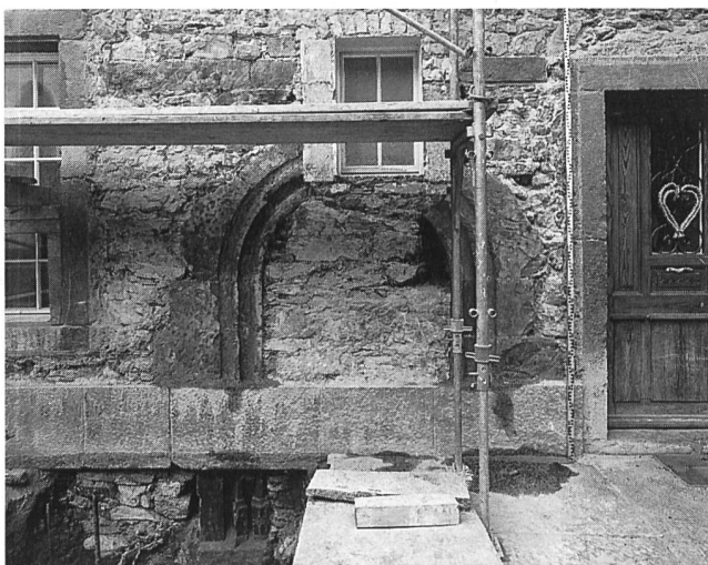
Abb. 179: Interlaken, Schloss. Das gotische Portal im Fundzustand.
