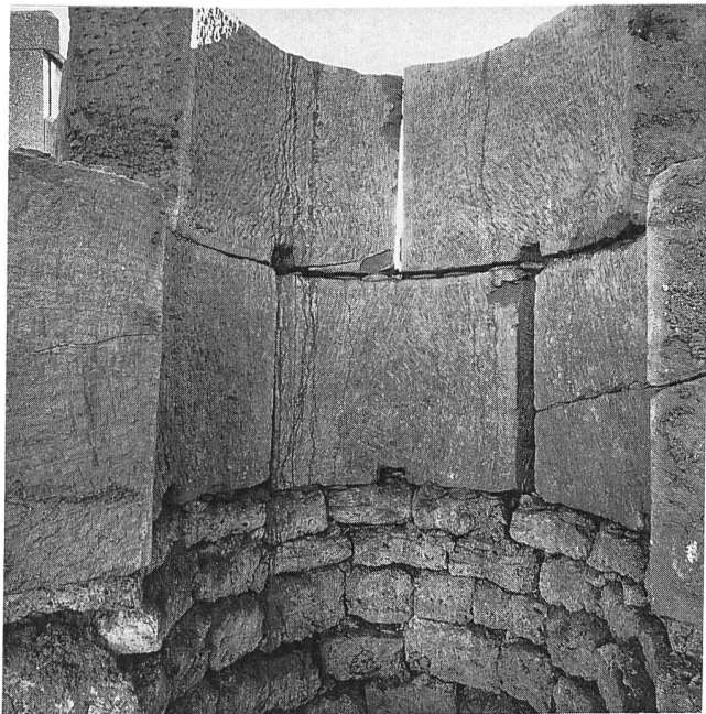
Abb. 107: Bern, Murtentor. Befunddetail des Materialwechsels von Sandsteinquadern zu Tuffmauerwerk.
