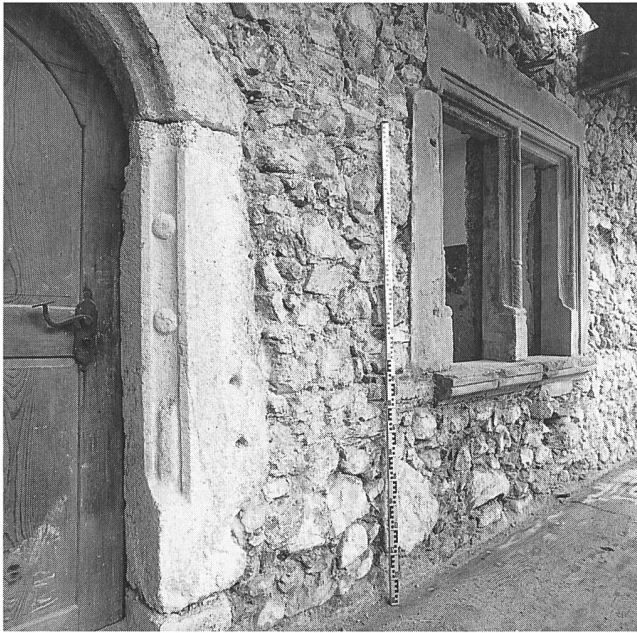
Abb. 274: Wiedlisbach, Mühle. Portaldetail mit Bollen in Kehlung.
