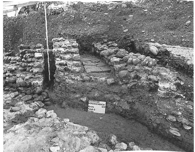
Abb. 17: Herzogenbuchsee-Finstergasse/nördliche Kirchhofmauer 1990. Abwasserkanal 2. Der Kanal ist in ältere Schuttschichten eingetieft. Am linken Bildrand erkennt man die Mauer 24, am rechten Bildrand die Koffering der alten Finstergasse. Blickrichtung Südosten.
