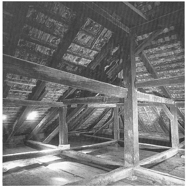
Abb. 6: Dachstuhl Bälliz 75. Blick nach Südwesten.
