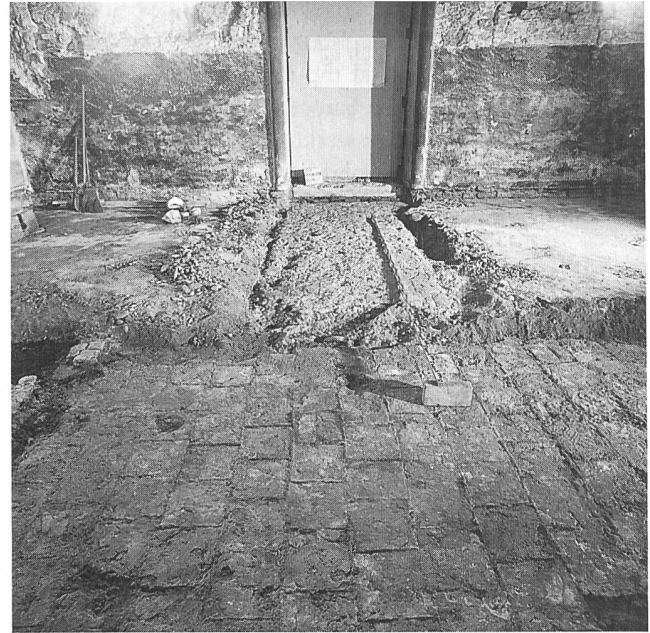
Abb. 14: Verlegemörtel des gotischen (Vordergrund) und barocken (Quer-gang) Tonplattenbodens.
