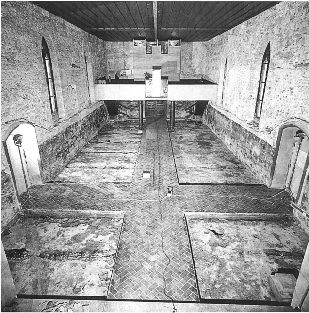
Abb. 2: Das Innere der Kirche während den Untersuchungen. In den Korridoren ist noch der Boden von 1932 zu sehen.
