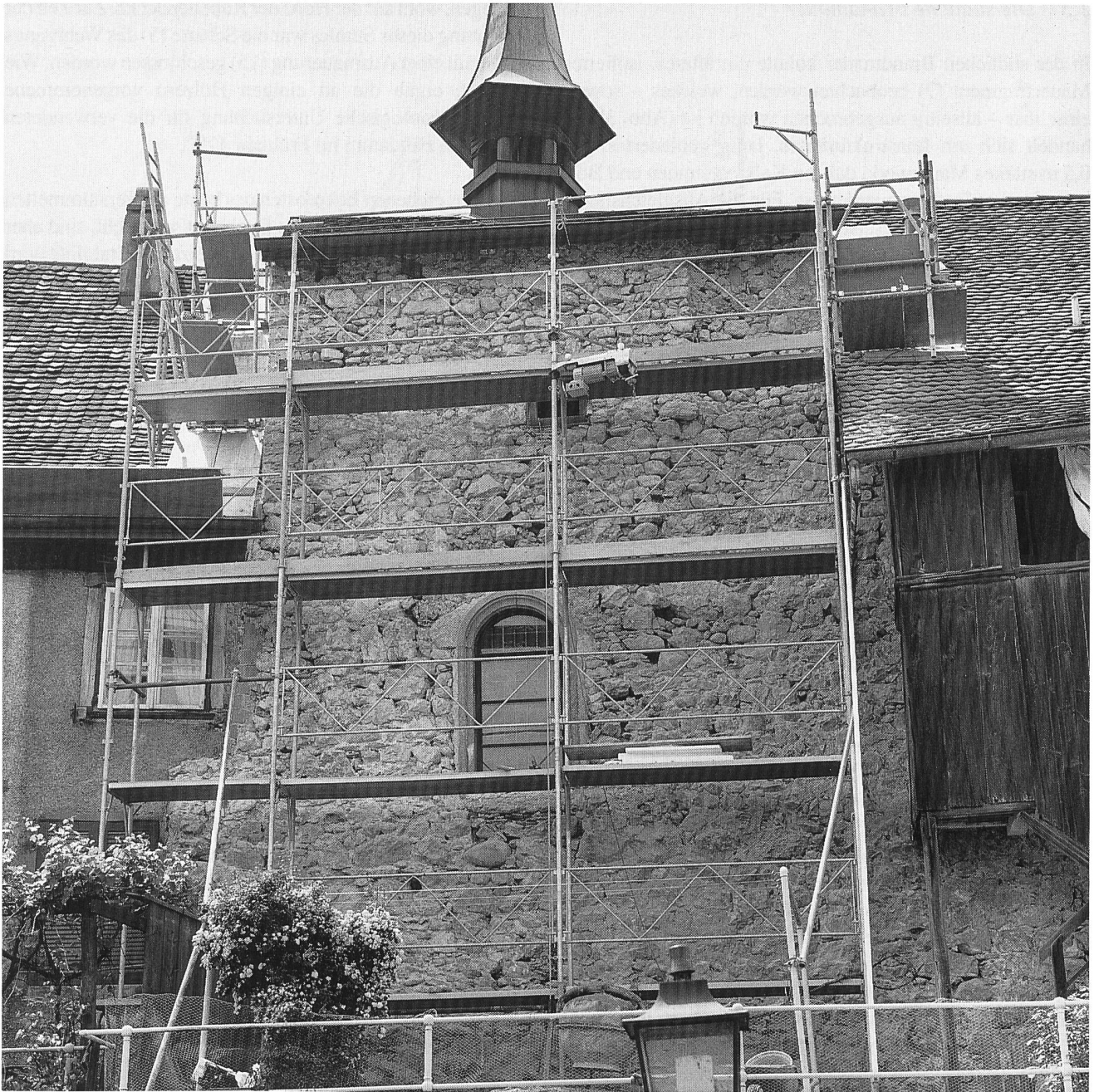
Abb. 2: Die Ostfassade im Zustand der archäologischen Untersuchung.
