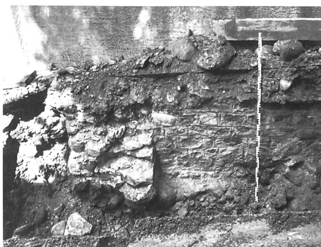
Abb. 19: Bern-Bümpliz - Mauritiuskirche 1969. Umbruch der Mauer a nach Osten. Der Mauerwinkel ist im Verband aufgebaut. Blick nach Westen.
