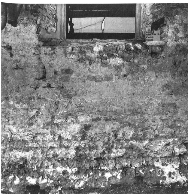
Abb. 3: Mauerwerk (100) der Anlage IV.
