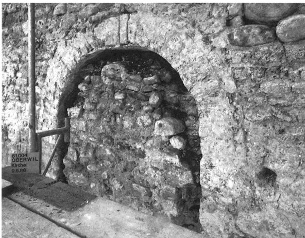
Abb. 5: Der Bogen (104) des Einganges an der Nordwestecke.
