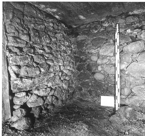
Abb. 4: Einblick in die Südstecke des Kellers U1.
