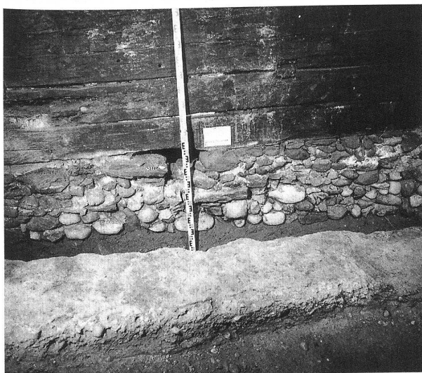
Abb. 10: Fundament der Küche E1 nach Westen.
