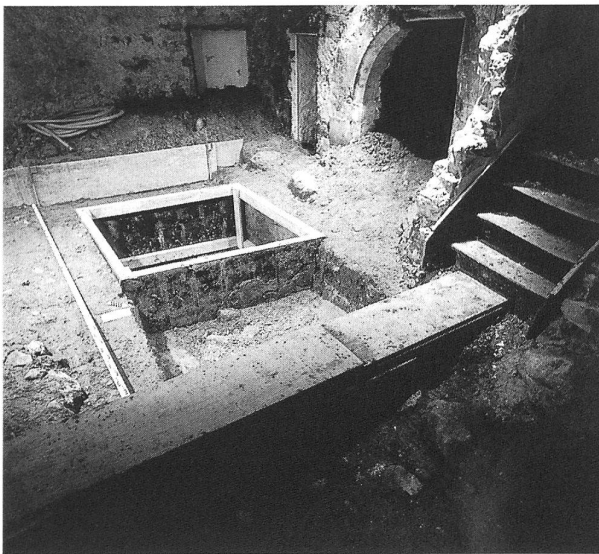
Fig. 3: Situation de fouille, vue vers l'ouest.
