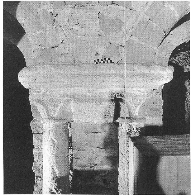
Fig. 10: Baie double, posée sur deux colonnes (2.2.9).
