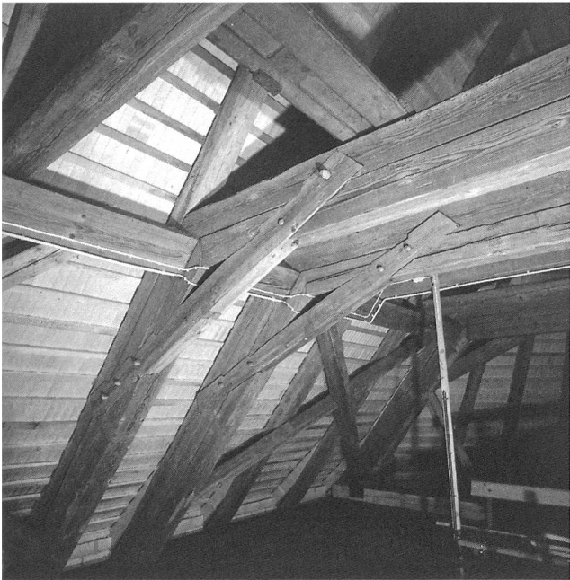
Abb. 16: Kopfhölzer der Dachstuhlkonstruktion des 17. Jahrhunderts.
