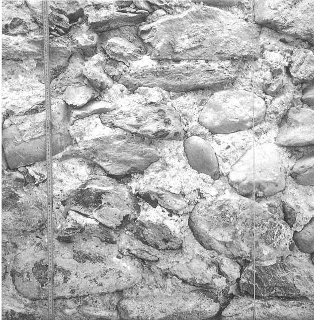
Abb. 6: Nordfassade, Mauerwerk der Anlage I.
