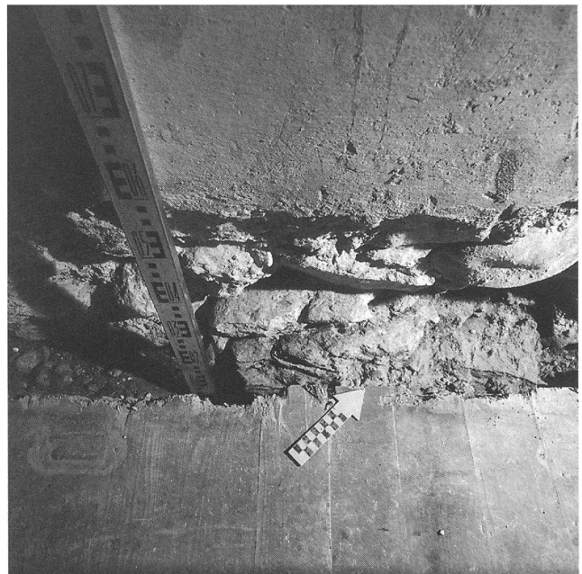
Abb. 11: Detail Nordwestecke von Anlage I.
