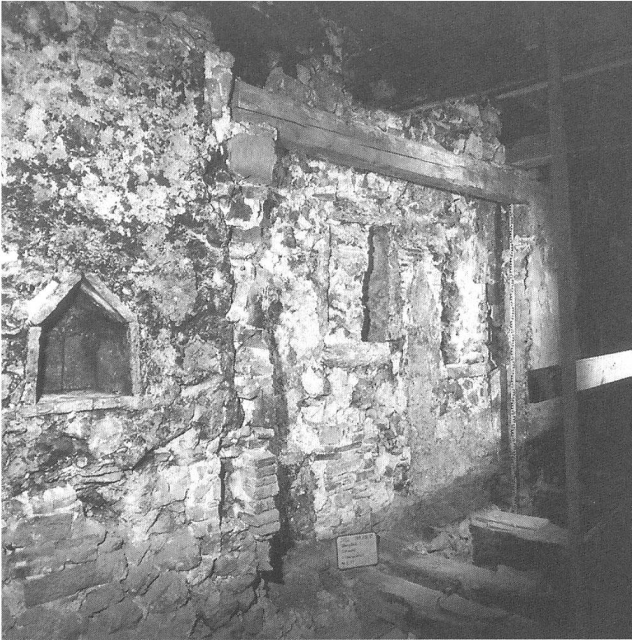
Abb. 13: Biel, Obergässli 5. Ostmauer (14) im 1. Obergeschoss mit Lichtnische (67) im Vordergrund, Blick nach Südosten.
