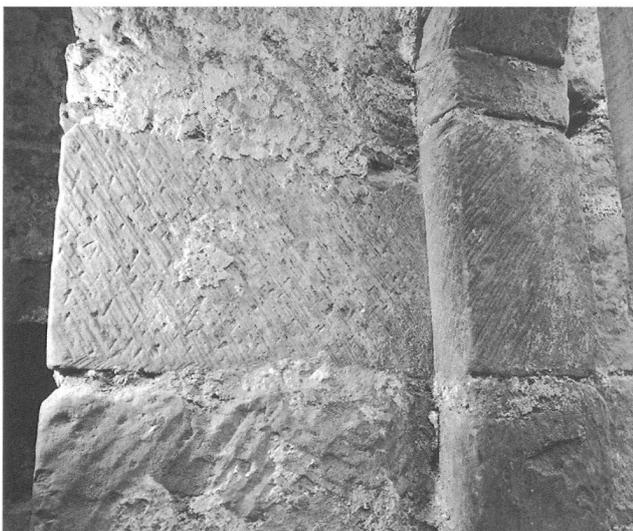
Abb. 21: Geflächte Gewändequader der Rundbogentüre.
