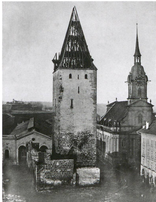
Abb. 6: Bern, Bahnhofplatz. Der Christoffelturm nach Beginn der Abbrucharbeiten, Aufnahme wohl Januar/Februar 1865.
