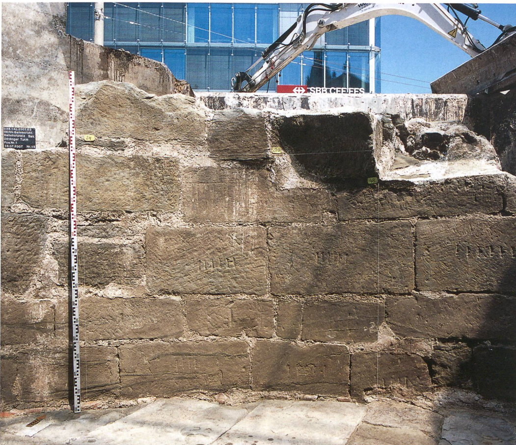
Abb. 25: Bern, Bahnhofplatz. Steinbehau und Schicht-höhenzeichen im Dittlinger-Turm.
