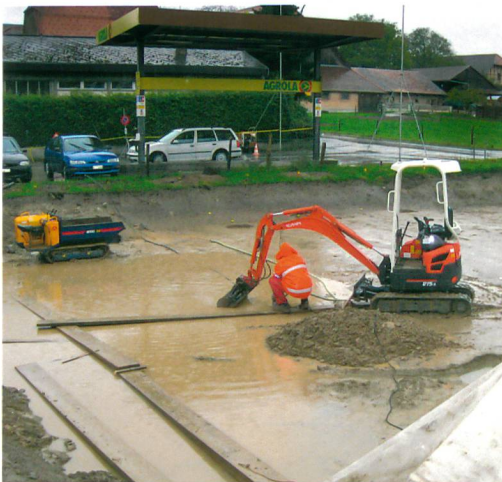
Fig. 7: Jegenstorf, Zuzwilstrasse. Ni la pluie ni la neige ne suffisent à empêcher le travail des archéologues.
