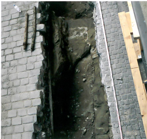
Abb. 6: Bern, Kornhausplatz/ Theaterplatz/Marktgasse. Blick auf die Fundamente des Gesellschaftshauses zu Pfis- tern (vgl. Abb. 1,5).
