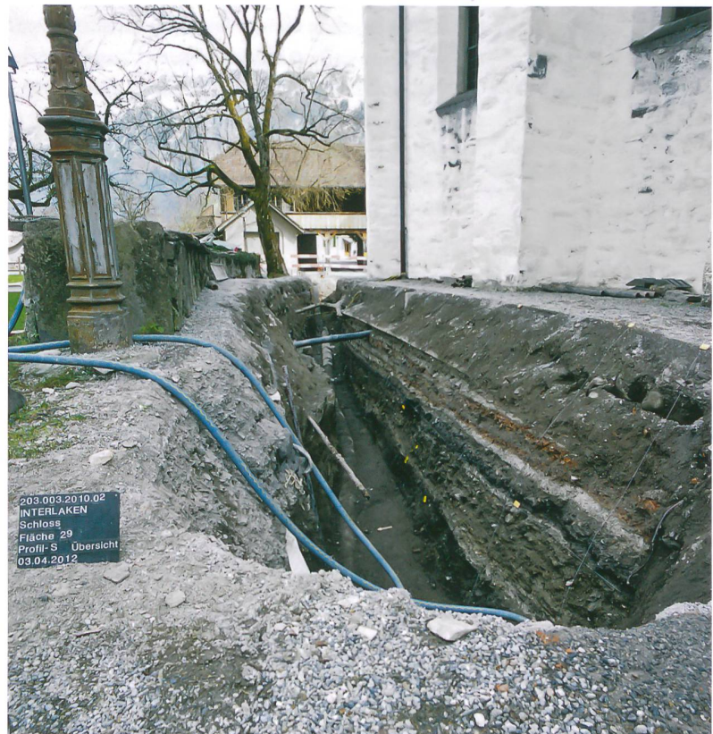
Fig. 12: Interlaken, Schloss. Tranchée creusée pour une conduite au nord de l'église.
