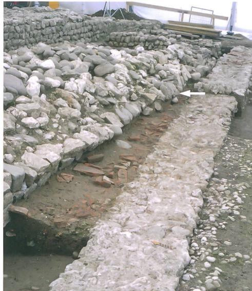
Abb. 8: Attiswil, Leimenstrasse 15. Das Fundament der Portikusmauer ist talwärts abgekippt (Pfeil). Blick nach Osten.
