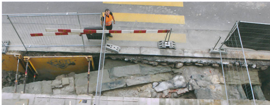
Abb. 2: Bern, Kochergasse. Übersicht vom Balkon des Parlamentsgebäudes. Man erkennt links die obere Steinlage des Brückenbogens und rechts die Fundamente des alten Torturms.
