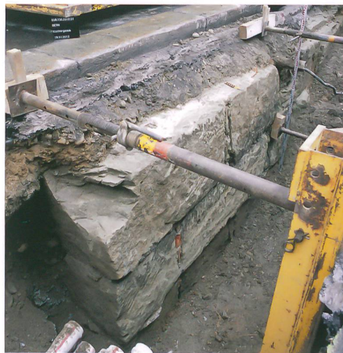
Abb. 4: Bern, Kochergasse. Ansicht der massiven Quadermauer des alten Inselspitals nach Westen.
