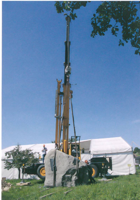
Abb. 2: Oberbipp, Steingasse. Der Deckstein wurde mit dem Kran abgehoben. Hier ist die trapezförmige Bearbeitung der Platte zu erkennen.
