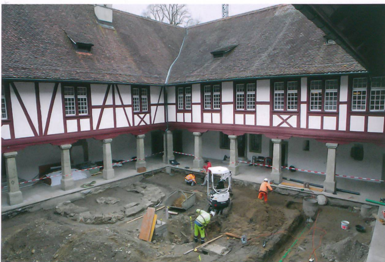
Abb. 1: Seedorf, Kloster Frienisberg. Barockzeitlicher Klosterhof mit dem Fundament des mittelalterlichen Brunnenhauses während der Sanierung 2012.
