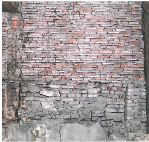
Abb. 17: Thun, Obere Hauptgasse 3. Detail der südöstlichen Giebelwand. Mit der verputzten Wand 71 (unten) wurde kurz nach 1571 ein durchgehender Raum im Hinterhaus 6 (um 1530) abgeteilt. Darüber erhebt sich eine aus wiederverwendeten Tonplatten und Abbruchmaterial bestehende Mauer 72. Blick nach Südosten.
