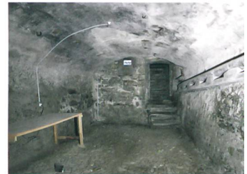
110 Unterseen, Obere Gasse 6
