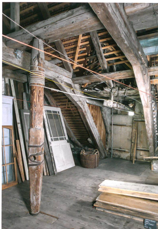
Abb. 3: Ligerz, Chlyne Twann 7. Dachgeschoss. Der Aufzugsgiebel wurde zusammen mit dem Dachstuhl gebaut. Links im Bild ist die originale Winde zu sehen, mit deren Hilfe die Lasten unters Dach befördert werden. Blick nach Südosten.
