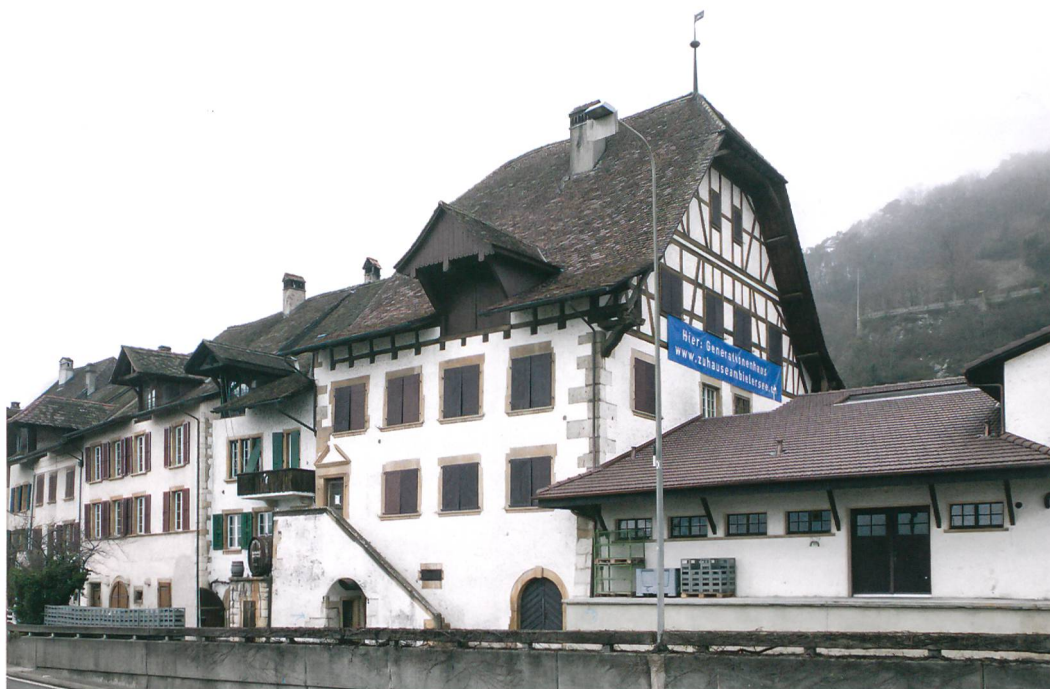
Abb. 7: Twann, Chlyne Twann 20. Südfassade, Ansicht von der Seeseite mit dem nachträglich angefügten Treppenaufgang.
