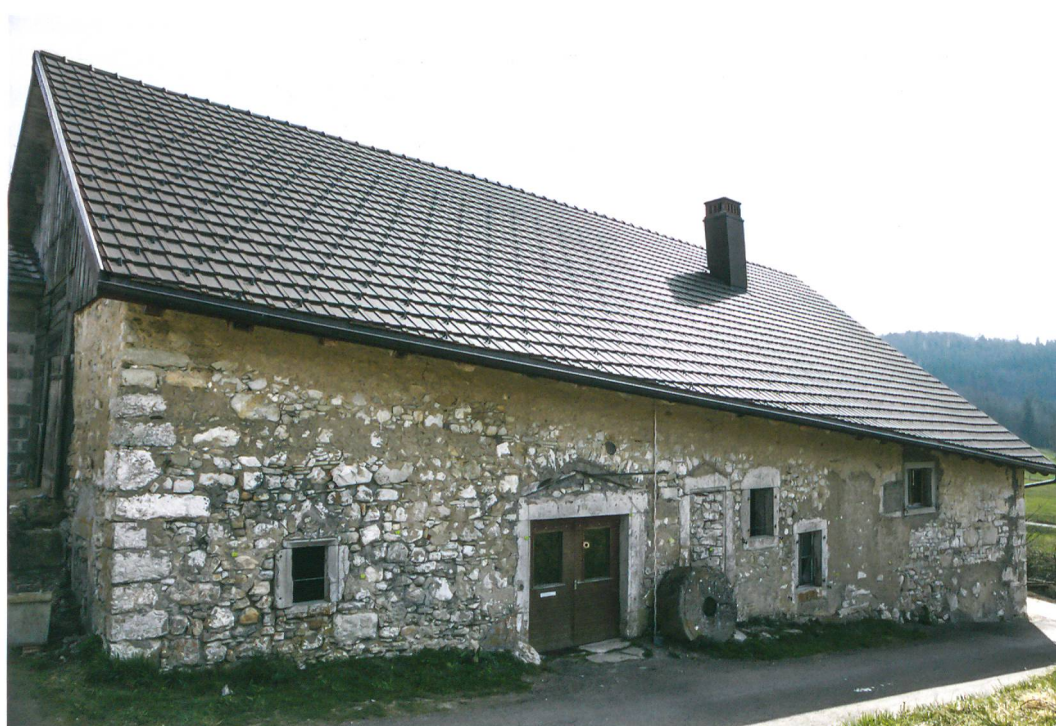
Fig. 6: Plateau de Diesse, Lamboing, Les Moulins 1. Façade ouest avant travaux. Diverses baies, parfois obturées, témoignent des modifications apportées au bâtiment au cours des générations.
