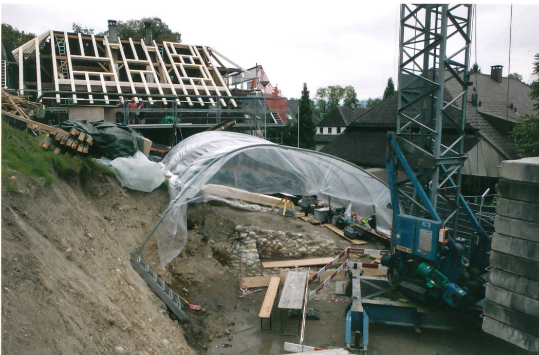
Abb. 1: Langnau, Hinterdorfstrasse 25. Grabungssituation im September 2014. Blick nach Osten.
