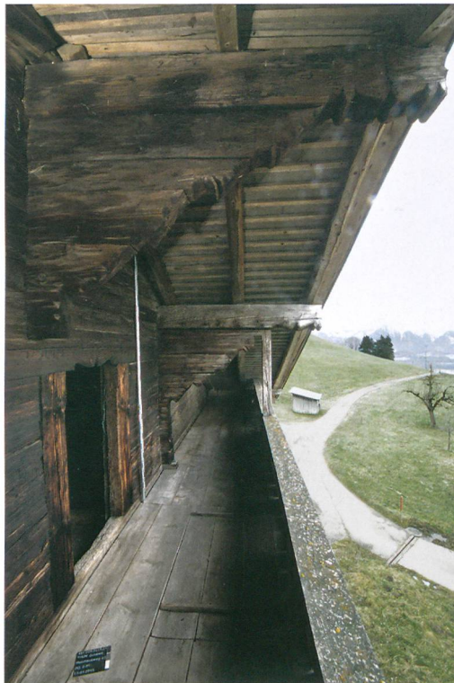
Abb. 3: Thun, Goldwil, Matthausweg 23. Die Blockkonsolen im Giebfeld sind mit zeit-typischen Einschnitten und Abfasungen verziert. Auf dem Sturzholz der Türe zur Bühnslaube befindet sich die Bauinschrift «1614 VLI RÄBER». Blick nach Süden.
