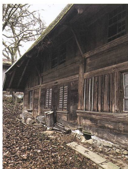
74 Seeberg, Grasswil, Unterdorfstrasse 42
