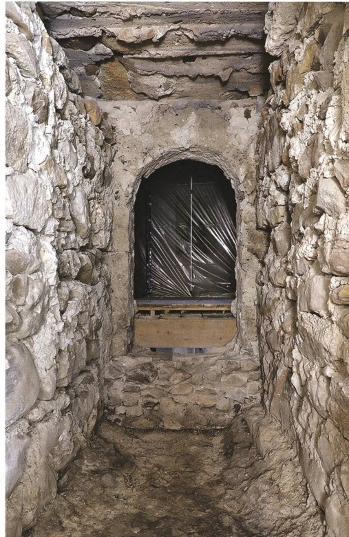
Abb. 5: Grosshöchstetten, Schlosswil, Schloss Wyl. Blick durch den wiedergeöffneten Hocheingang ins Turminnere. Oben sind Negative der Balken, die den Durchgang abdeckten, zu erkennen. Die unverputzten Wände waren vielleicht mit einer Holzverschalung versehen.
