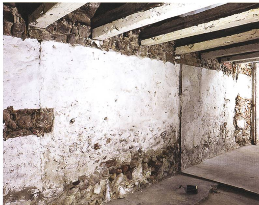
Fig. 2: La Neuveville, rue du Collège 5. Au rez-de-chaussée, mur mitoyen nord et solivage sont contemporains; ils ont été datés de 1374 par la dendrochronologie. Tout à droite de l'image, on devine les traces du mur d'enceinte de la ville.
