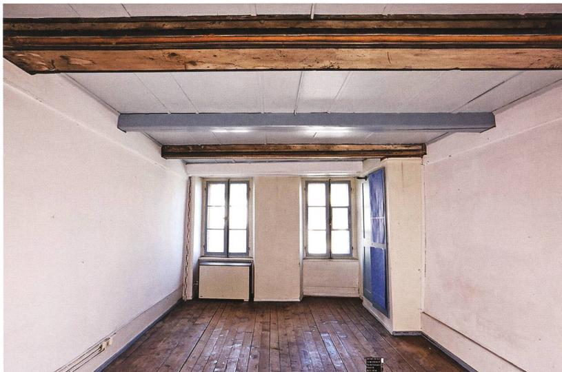
Fig. 6 : La Neuveville, rue du Collège 5. Les solives du plafond de la pièce 16, au 2<sup>e</sup> étage, étaient moulurées et se rapportaient à une phase de transformation ou de rehaussement du bâtiment datée de 1507. Le plafond fut renforcé ultérieurement par des solives supplémentaires. Vue vers l'est.
