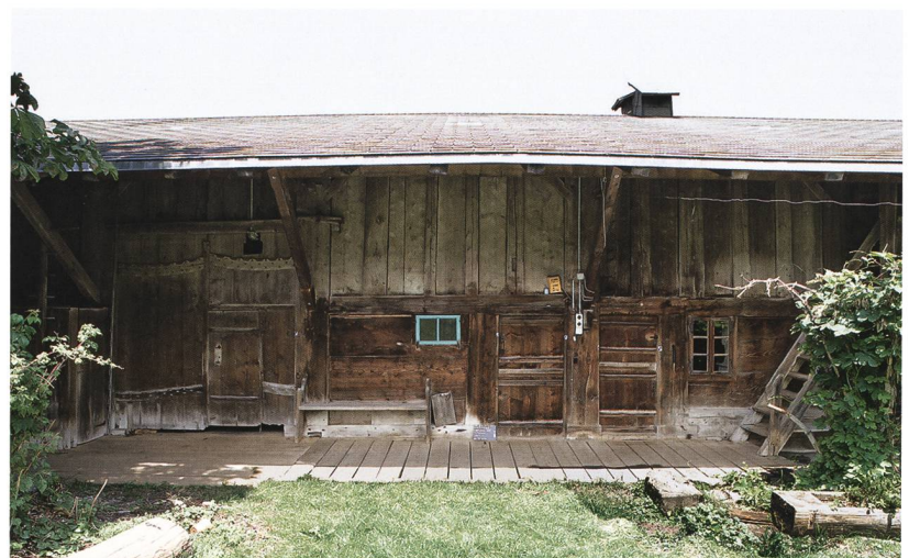
Abb. 16: Rüschegg Sangern 183. Südliche Haushälfte zwischen dem zweiten und fünften Querband. Abgesehen von den vergrösserten Fenstern präsentiert sich dieser Bereich in ursprünglicher Gestalt. Blick nach Norden.
