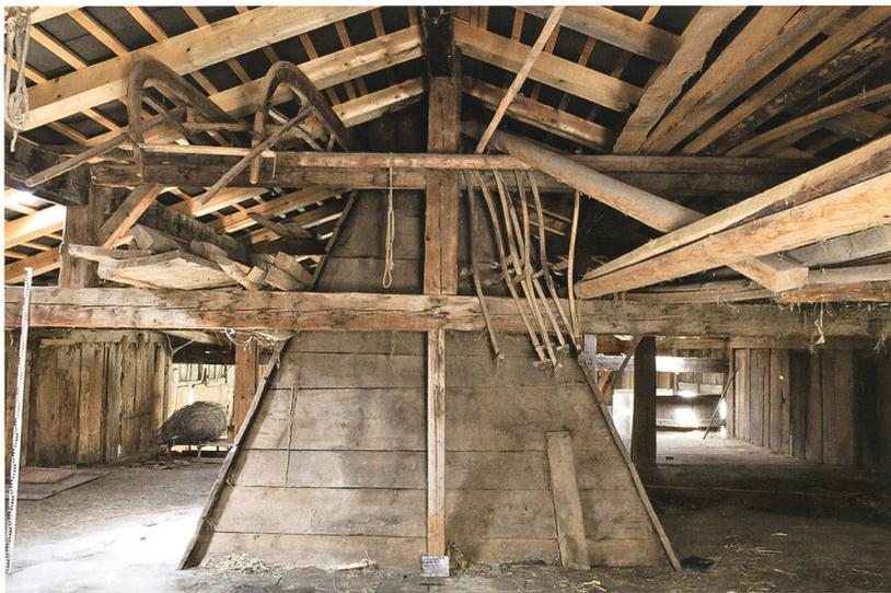
Abb. 21: Rüscheegg Sängern 183. Die hölzerne Rauchhütte (111) wurde 1859 erstellt. Für die Verankerung dieser Konstruktion mussten alle inneren Pfettenständer unterhalb des dritten Ankerbalkens (9) entfernt werden. Damit dieses Langholz die Dachlast nicht frei bis zu den Traufseiten ableiten musste, fügte man einen Angstständer ein. Blick nach Westen.
