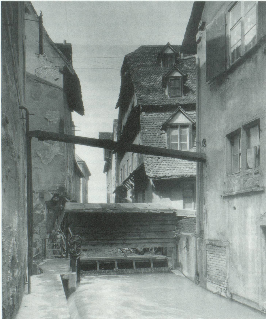
Das Dalbeloch vor der Restauration.
