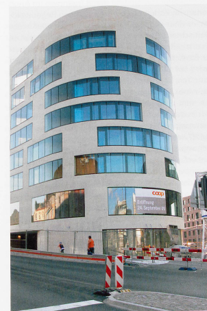
Bild S. 2 Baustelle beim Stückli
