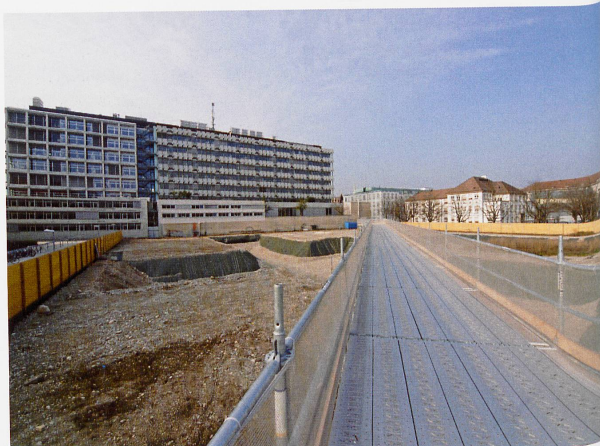
Schällemätteli damals (oben) und Baugrube heute.
