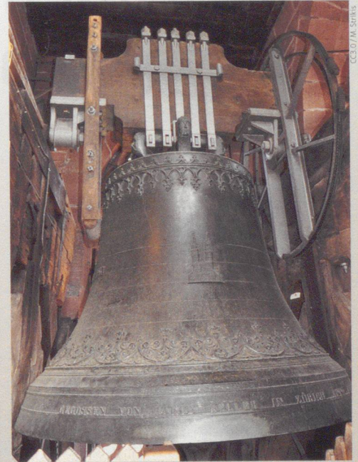
Die «Papstglocke» (auch «Grosse Glocke») von 1873 heisst so, weil sie Reste der von Papst Felix V. während des Basler Konzils (1431–1449) gestifteten Glocke enthält.
