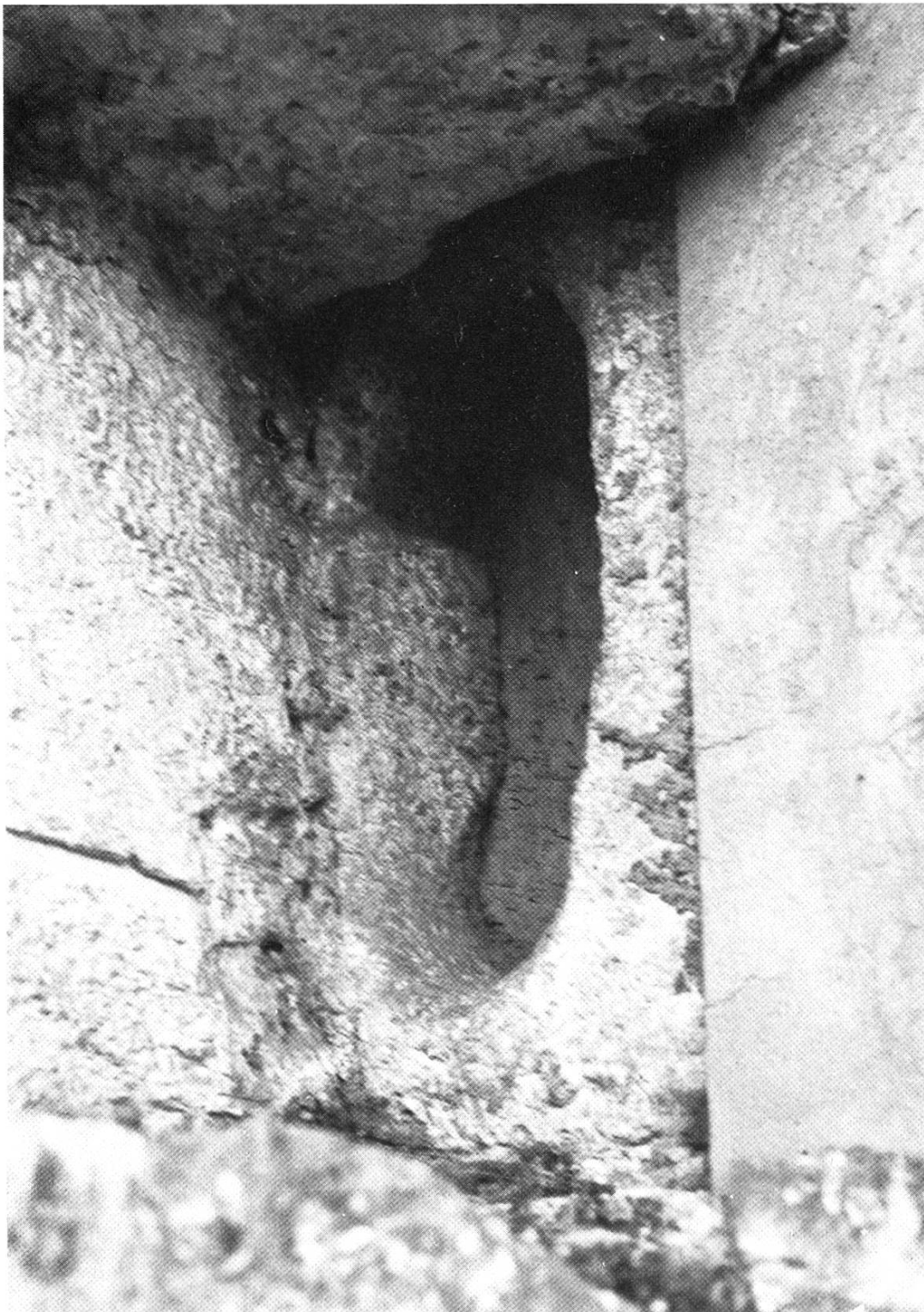
Abb. 39 Reste einer Schlüsselscharte mit oberem Querbalken im Eckhaus Hal- denring – Zollrain. Die zu einem ovalen Kellerfenster umgearbeitete Scharte wird teilweise vom heutigen Brückendamm verdeckt.
