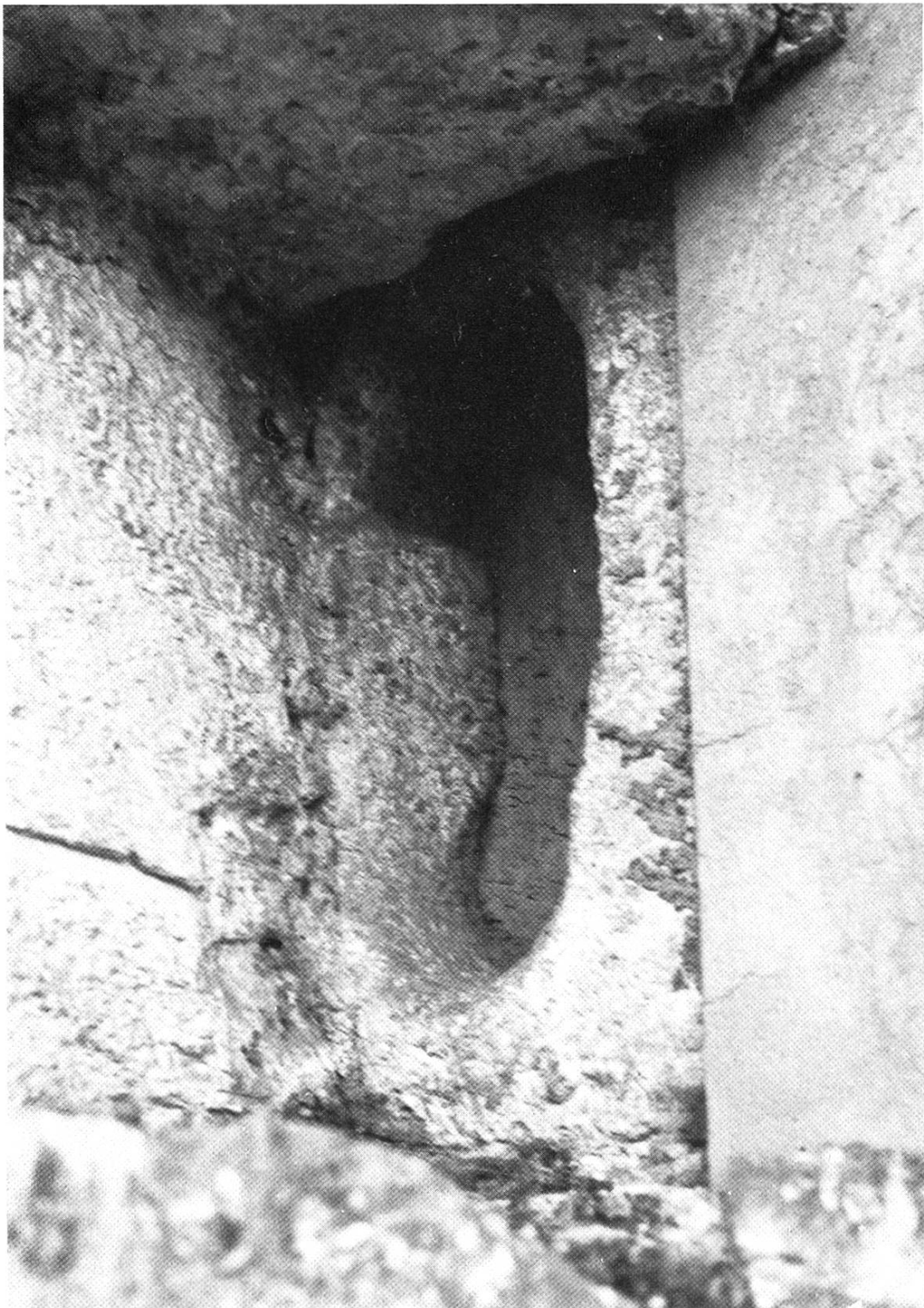
Abb. 39 Reste einer Schlüsselscharte mit oberem Querbalken im Eckhaus Hal- denring – Zollrain. Die zu einem ovalen Kellerfenster umgearbeitete Scharte wird teilweise vom heutigen Brückendamm verdeckt.
