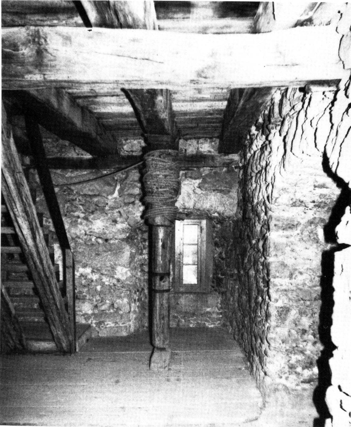
Südwestecke im 9. Geschoss mit Aufzughaspel
