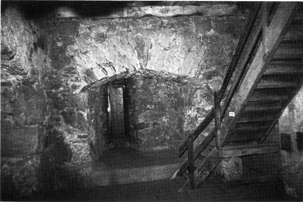
Westwand im 6. Geschoss
