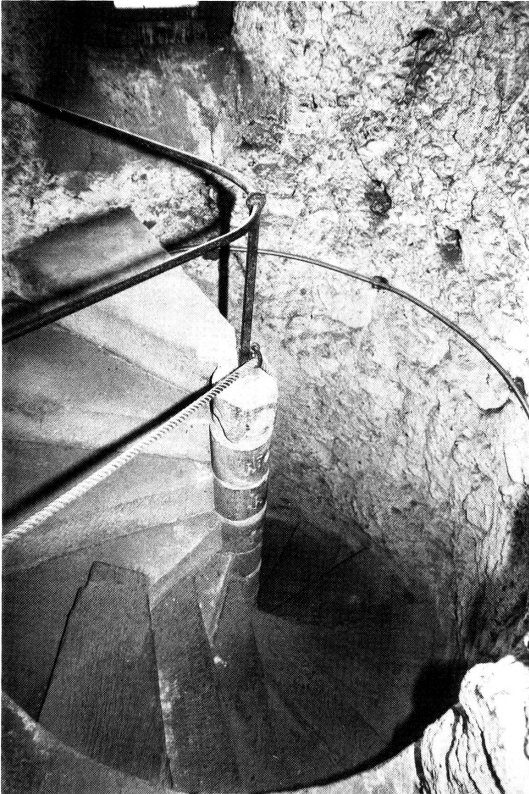
Oberes Ende der Wendeltreppe im 6. Geschoss
