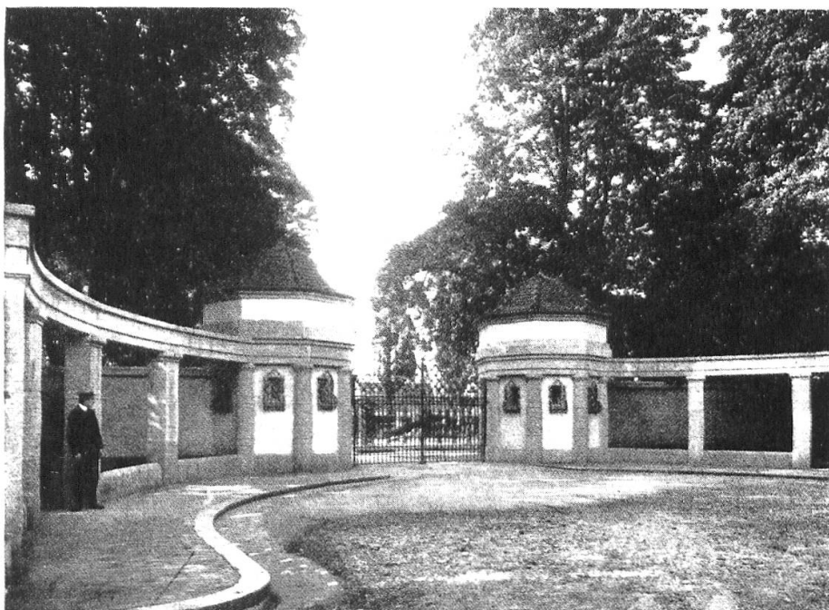
AUSSEN ANSICHT DES PORTALS MIT VORPLATZ
