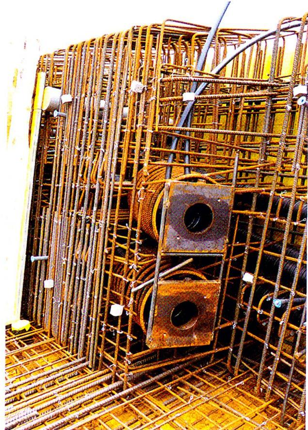
**10** Armierungsskizze der Verbindung Fahrbahnplatte – Hohlkastenstege. (Foto Christian Fritschi, Aarau.)
