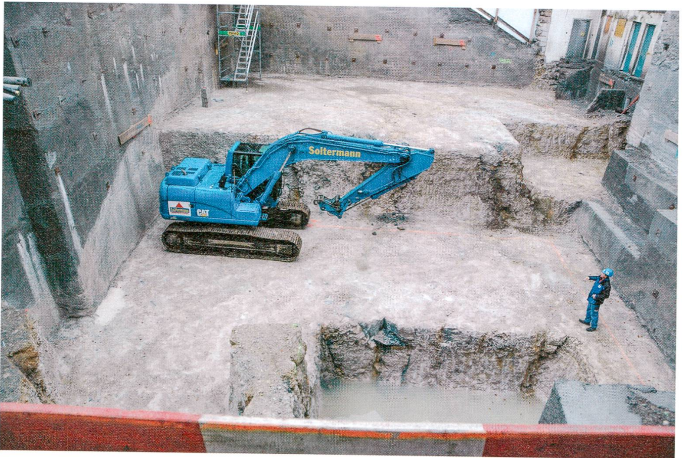
2 Die Baugrube ist ausgehoben.
