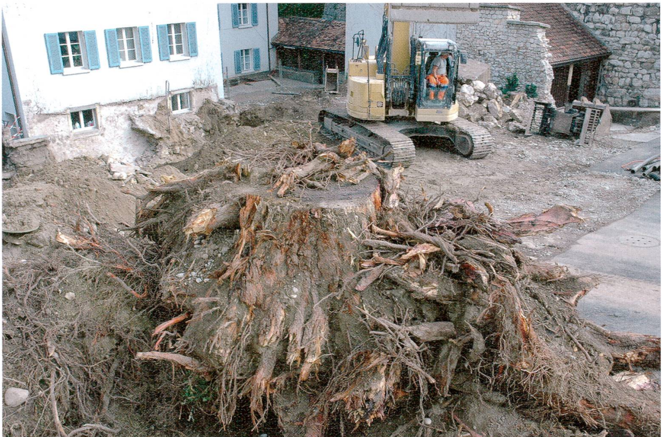
1 Die Bauarbeiten haben begonnen.
