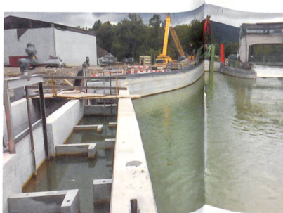
Links im Bild der Fischpass. Der Pfeil markiert den Bypass. (Foto: Thomas Stucki)
