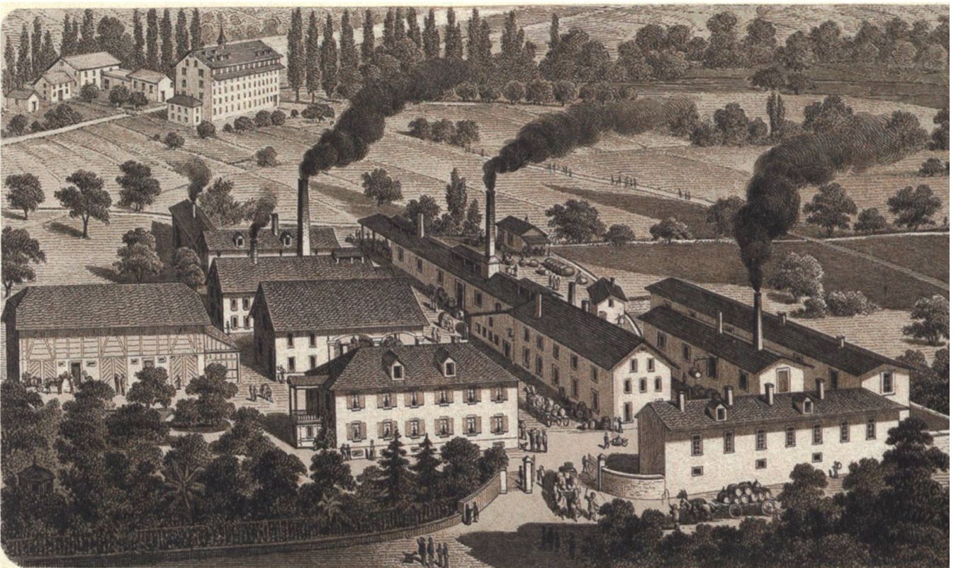
↑ Chemische Fabrik Frey in der Telli, Aarau, 1880. Im Hintergrund ersichtlich ist die von Friedrich Frey-Herosé errichtete Baumwollspinnerei und -weberei, die spätere Schokoladenfabrik. (Bild: Sammlung Stadtmuseum Aarau)
