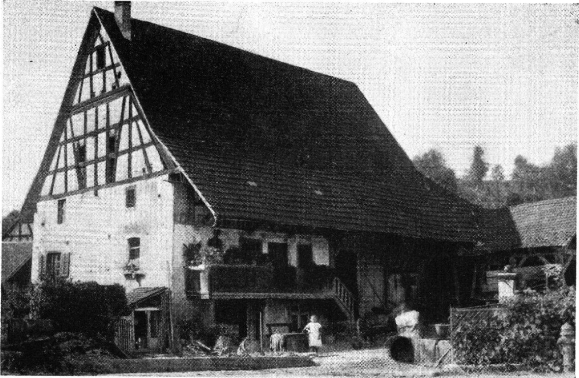
Bild 24. Elfingen. Riegelhaus. Eine Treppe führt zur Laube, welche die Verbindung der obern Räume herstellt. Zustand vor 1927, wo leider bei einer Renovation das Fachwerk übertüncht wurde.
