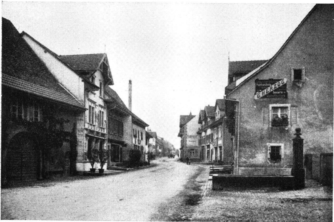
Bild 25. Frick, Hauptstraße, durch häßliche, neuzeitliche Umbauten in ihrem Bild beeinträchtigt.
