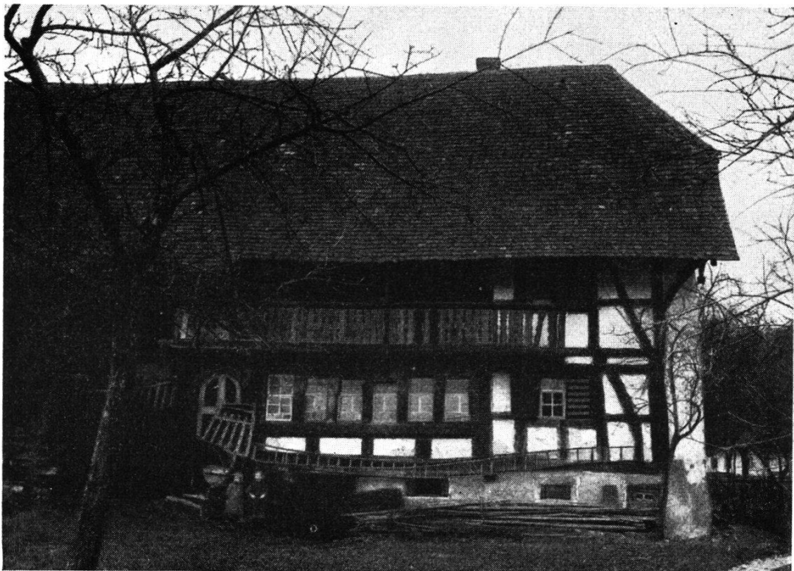
Bild 23. Hettenschwil. Riegelhaus mit Krüppelwalm. Aufgang zur Laube im Innern des Hauses. (Phot. Vosseler)
