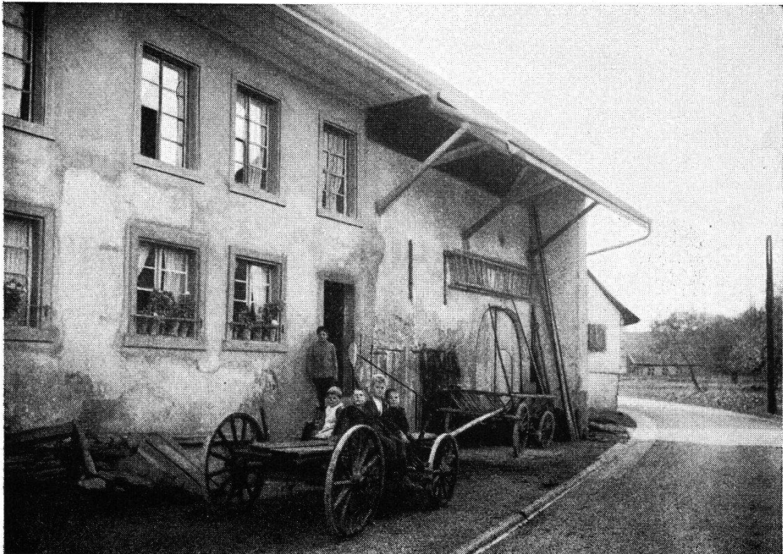
Bild 21. Oberfrick. Der Windschutz dient zugleich zum Stützen des Daches. (Phot. K. Bircher-Matthys, Aarau)
