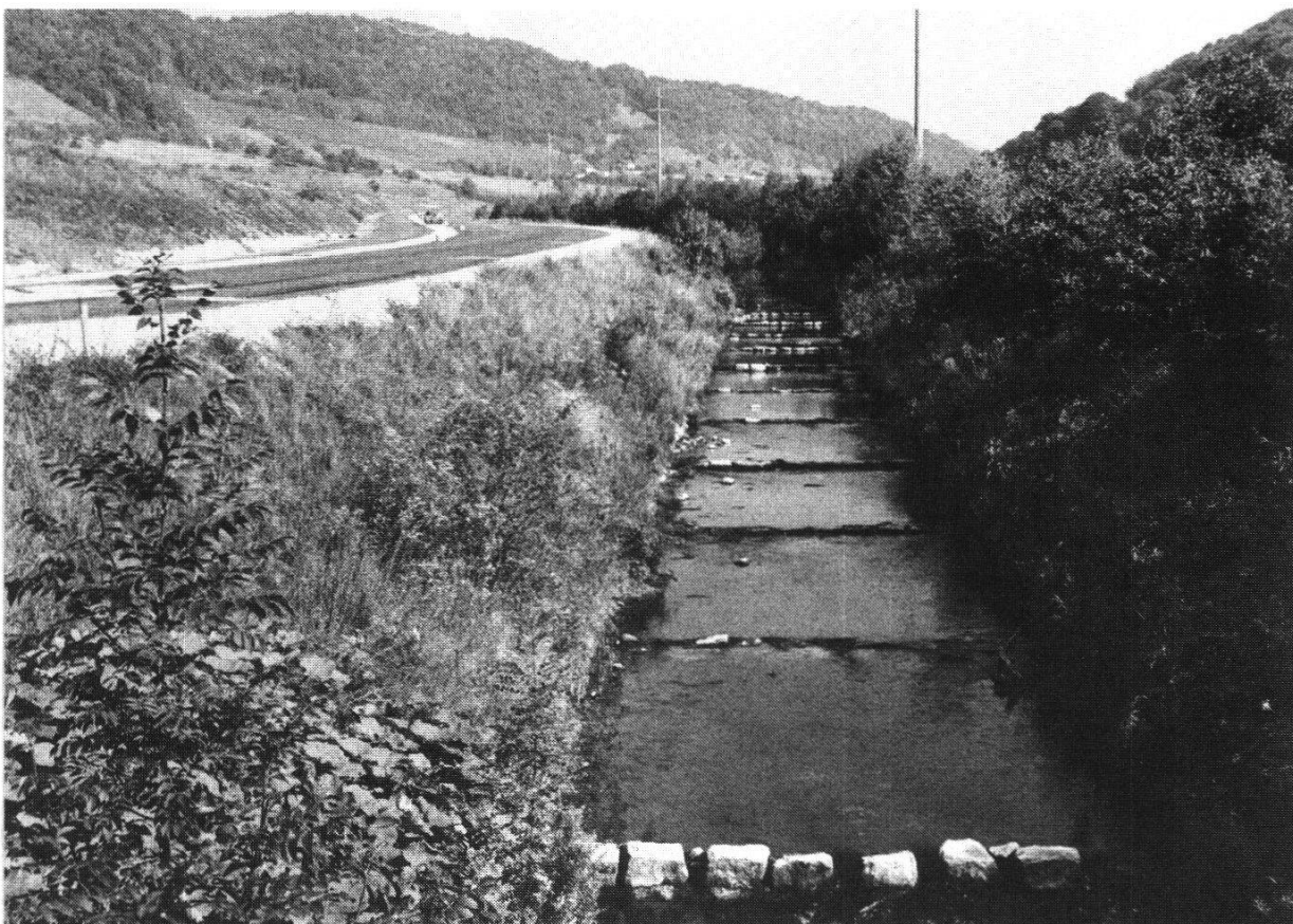
Abb. 7b: Begradigter, verbauter Bach. Sisselbach, Gemeinde Hornussen, direkt oberhalb Roggenmoos. Der beim Autobahnbau verlegte Bach ist mit einheitlichem, trapezförmigem Querprofil angelegt; die Ufer sind durchgehend mit Steinen befestigt; das Gefälle wird mit Schwellen in exakt regelmäßigen Abständen überbrückt. Wasseramsel und Bergstelze finden in diesem eintönigen Gewässer keine günstigen Lebensbedingungen. Foto H. Leuzinger, Rheinfelden.
